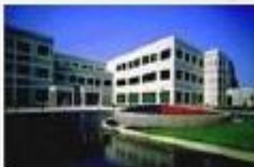
数据中心基础设施
